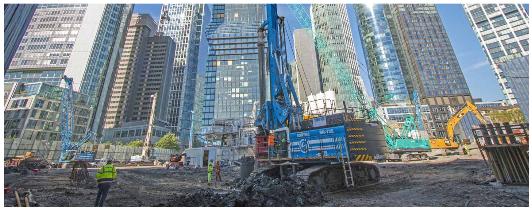
Consolidamenti per il Progetto "4 Frankfurt" - Germania
